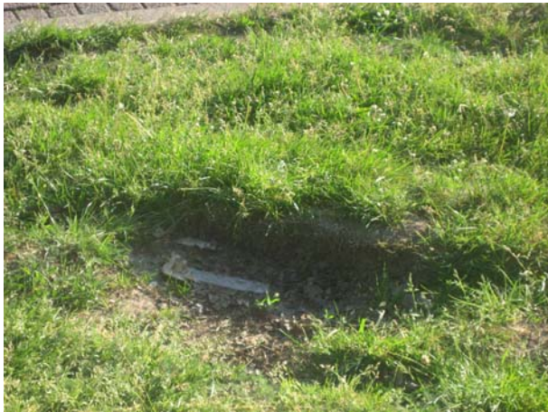
Er zijn gevaarlijke kuilen.
